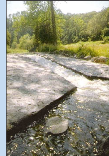
Foto 7: Scala Denil con deflettori sul fondo (Bretagna).
